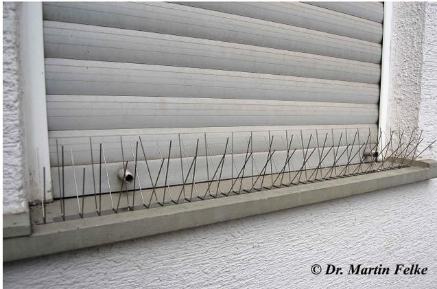
**Abbildung 2:** Taubenabwehrspitzen können verhindern, dass Tauben auf Fensterbänken oder Fassadenvorsprüngen landen
